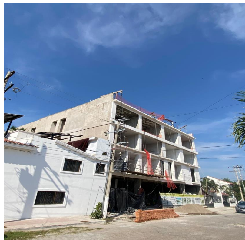
TERMINO DE FACHADA LATERAL IZQUIERDA.
