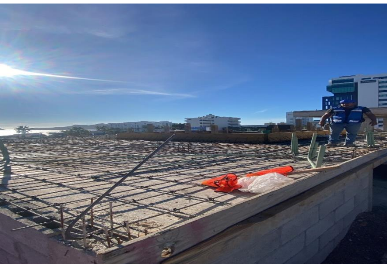
ARMADO DE LOSA PH
