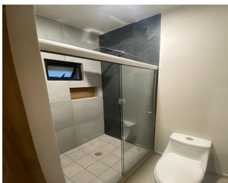
TERMINO DE COLOCACION CORREDIZAS DE ALUMINIO
